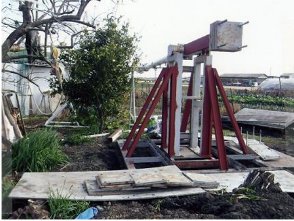
風車基礎の改良
